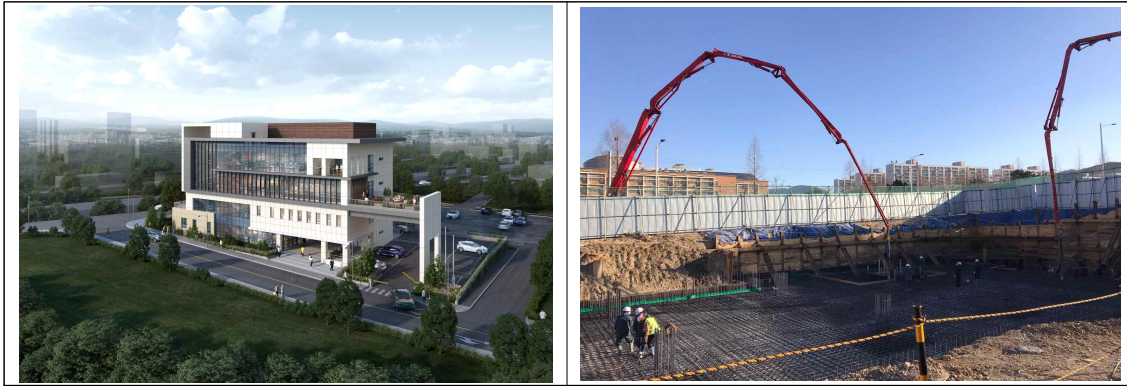
평생학습관 조감도 및 공사사진
