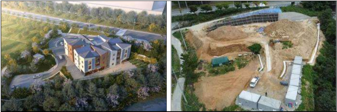
실버케어센터 조감도 및 공사사진
