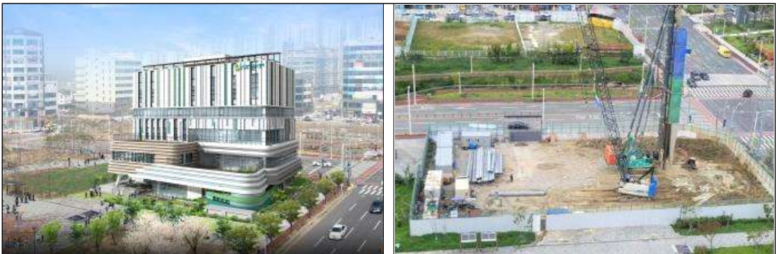
송정복합문화센터 조감도 및 공사사진
