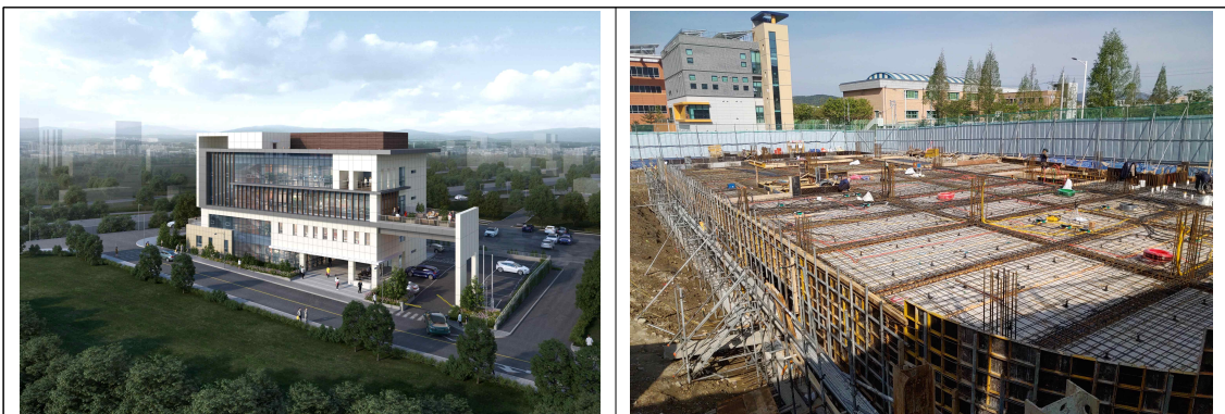
평생학습관 조감도 및 공사사진
